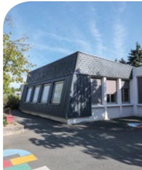
L'école Charcot a fait l'objet de travaux de rénovation énergétique
