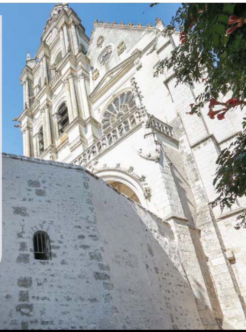
Le mur de soutènement des Grands degrés Saint-Louis a été rénové
