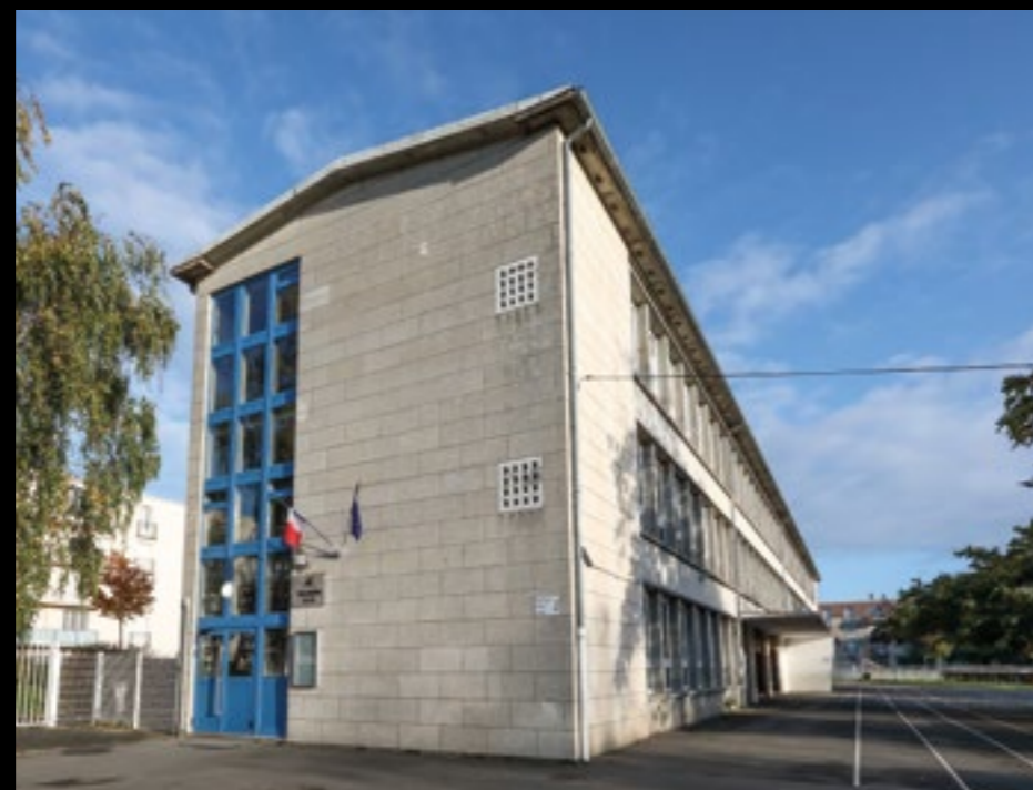
Les pignons de l'école Bel Air ont été rénovés pour un meilleur confort thermique
