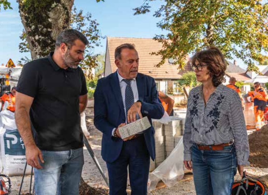
Visite du chantier d'aménagement de la place Clément Marot avec des pavés fabriqués à base de coquilles d'huîtres (qui laissent passer l'eau et restituent de la fraîcheur), en présence d'Ozgur Eski, adjoint en charge des travaux et Hélène Menou, adjointe en charge de la nature en ville
